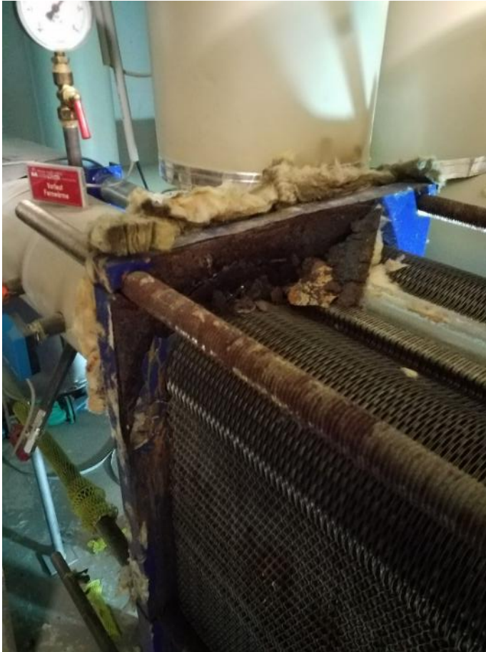
Abbildung Leckagen: Wasseraustritt an geschraubten Wärmetauschern oder Gleitringdichtungen
