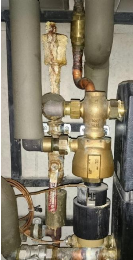
Abbildung Leckagen, Ablagerungen und Korrosion: Wasseraustritt mit massiven Salzkrusten, Ablagerungen von Kalk und Magnetit, Korrosion an wasserführenden Bauteilen.
