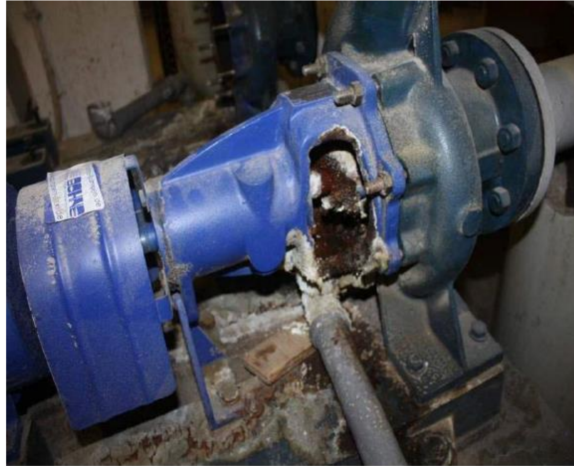
Abbildung Leckagen: Wasseraustritt an geschraubten Wärmetauschern oder Gleitringdichtungen
