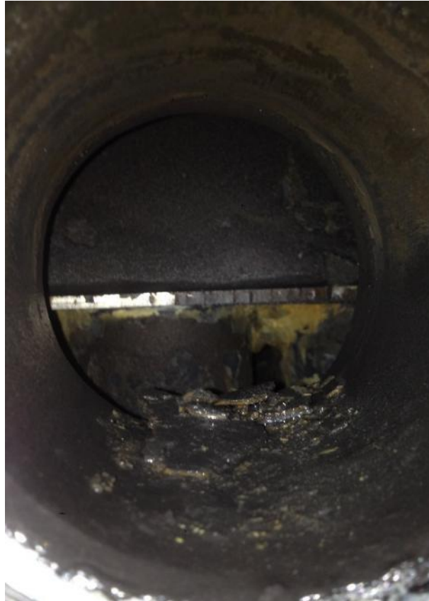
Abbildung Leckagen, Ablagerungen und Korrosion: Wasseraustritt mit massiven Salzkrusten, Ablagerungen von Kalk und Magnetit, Korrosion an wasserführenden Bauteilen.
